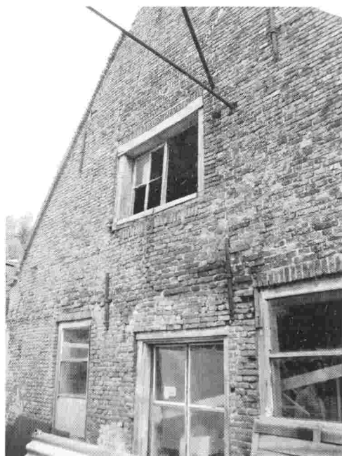
Eén van de pandjes in de Laanstraatbuurt die op de nominatie voor restauratie staan.
