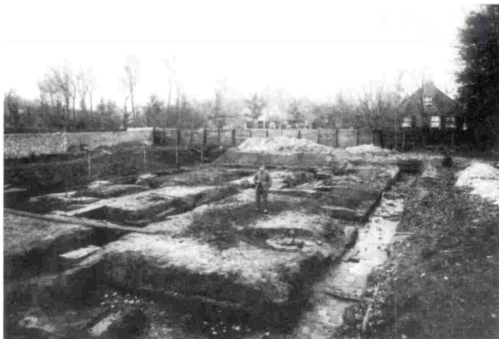
Opgravingen in 1911 van de fundamenteën van het huis Sypesteyn.
