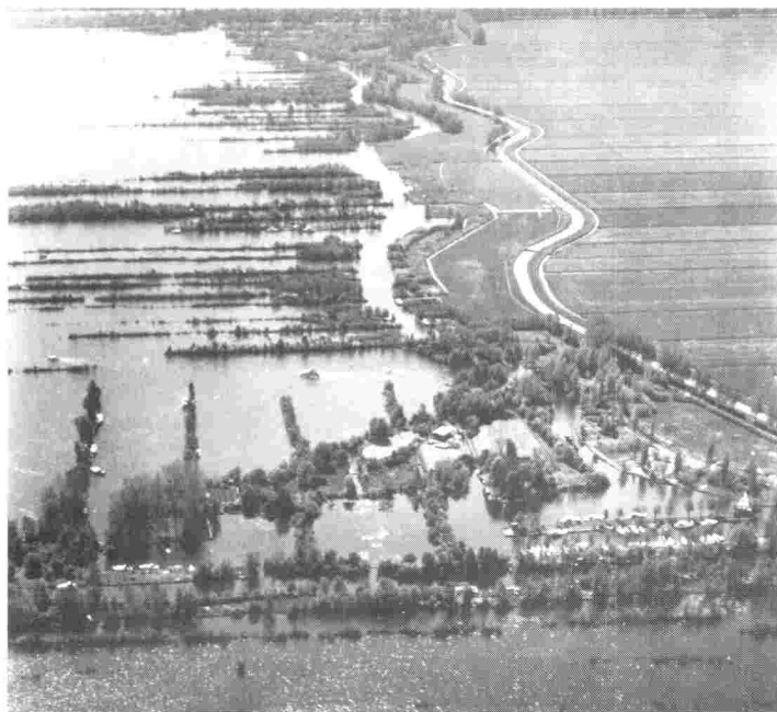
Luchtfoto Loosdrechtse Plas met rechts het waterleidingkanaal.
