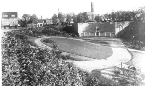
De zout- en zandbunker aan de Oude Haven in Hilversum (coll. Streekarchief te Hilversum)
