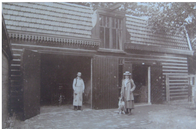
Fietsenstalling en dierenverblijf (foto E. Zeiler).
