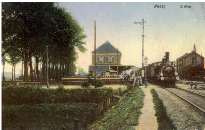
Het in 1967 gesloopte station Weesp.
