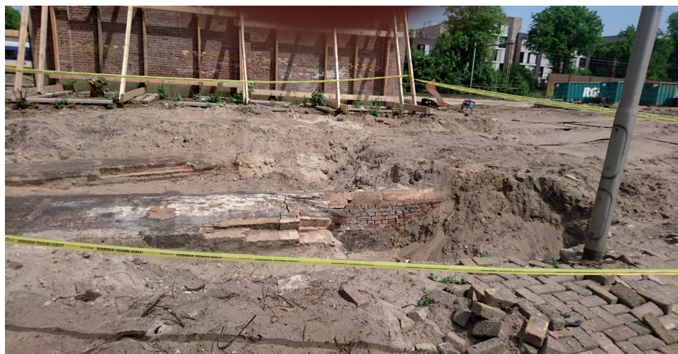
Bij de sloop van het fabrieksterrein komen de gemetselde rookkanalen tevoorschijn (foto auteur, 17 mei 2017).
