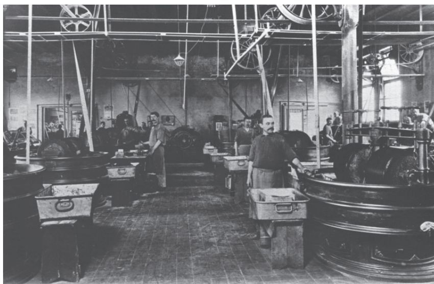
In de broyeerkamer wordt de cacaomassa bij een bepaalde temperatuur gewalst. De temperatuur wordt bereikt met stoven, de walsen worden aangedreven door middel van drijfriemen die zijn verbonden aan een in de plafondconstructie gemonteerde centrale drijfjas.
