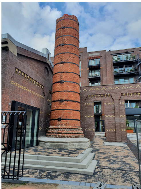
De gerestaureerde schoorsteen (foto auteur, 1 juni 2022).
