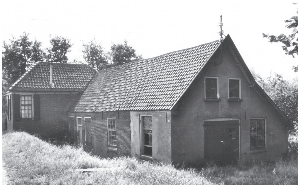
Afb. 7. Wakkerendijk 170 in vervallen toestand in 1959 (foto G.Th. Delemare, Rijksdienst voor het Cultureel Erfgoed). Het nieuwe afgewolfde rieten dak zou hoger worden om slaapkamers te creëren.
