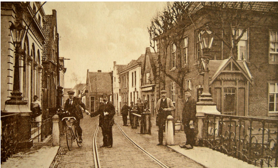
Sluis met rechts het tolhuis.
